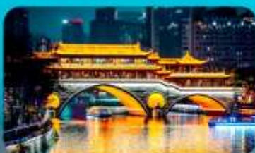
สะพานอันชุน
