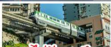
รถไฟไฟฟ้าทะลุถ้ำ
